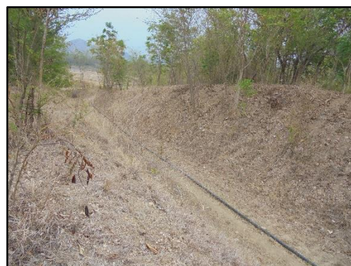
ภาพที่ 2.2 คันทำนบล้อมรอบพื้นที่ลานกองเก็บเปลือกดินและเศษหิน
