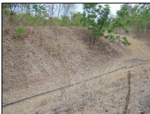
ภาพที่ 2.2 คันทำนบล้อมรอบพื้นที่ลานกองเก็บเปลือกดินและเศษหิน
